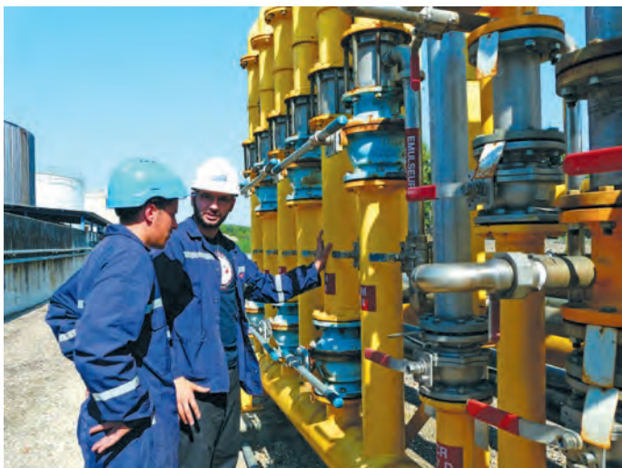
Formation par compagnonnage sur le système de défense incendie.
